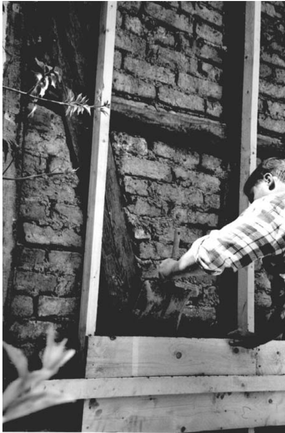
Abb. 4: Das kann jeder: Einfüllen des Wärmedämmlehms
