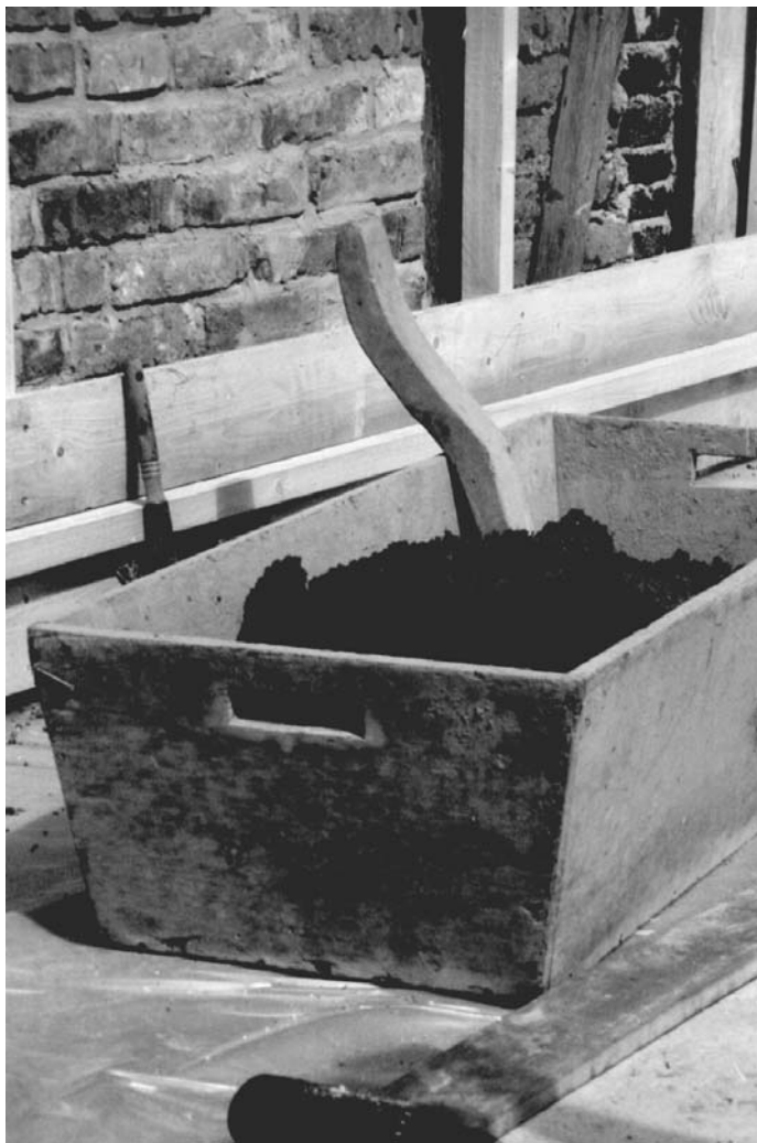
Abb. 3: Im Vordergrund: Verarbeitungsfertiger Wärmedämmlehm Im Hintergrund: Sparschalung auf Ausgleichslattung
