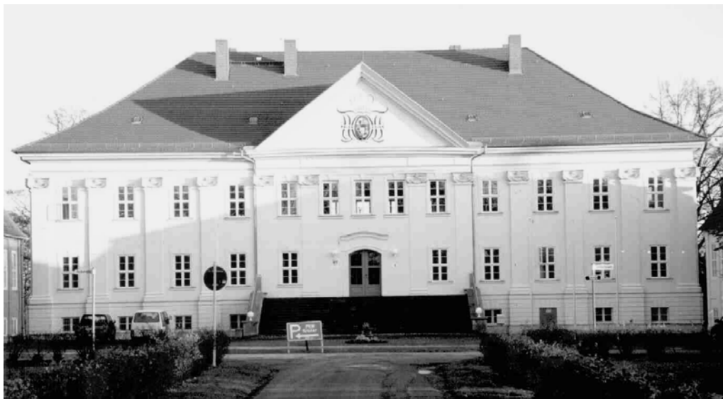
Abb. 7: Schloss Hohenzieritz mit raumseitigem Wärmedämmlehm nach Abschluss der Restaurierungsarbeiten im Jahr 2000
