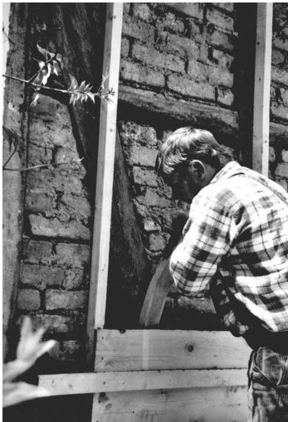
Abb. 5: Das kann jeder: Verdichtung des Wärmedämmlehms
